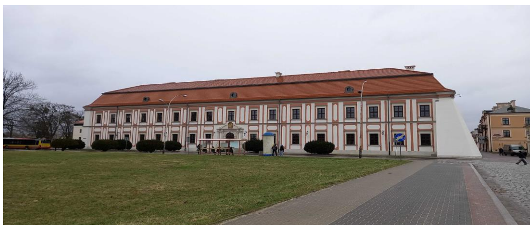
Widok na Akademię Zamojską od strony zachodniej
