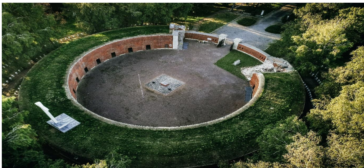
fot. Szymon Łyciuk Fragment zewnętrznego muru Rotundy Zamojskiej
