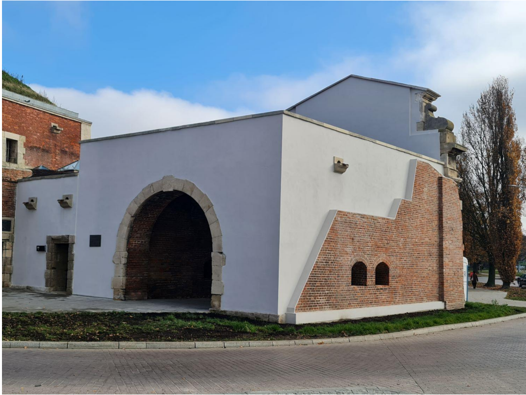
19 Brama Lwowska Stara po pracach remontowo-konserwatorskich, fot. R. Kondraciuk, z zasobów UM Zamość
