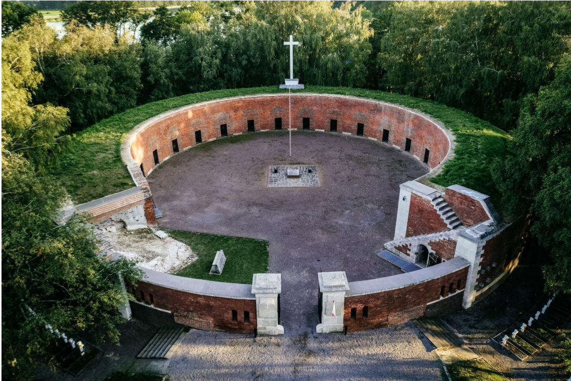
21 Rotunda, realizacja projektu „Rewitalizacja Rotundy Zamojskiej w Zamościu” – remont konserwatorski, rozbudowa ekspozycji muzealnej, fot. Sz. Łyciuk, z zasobów UM Zamość
