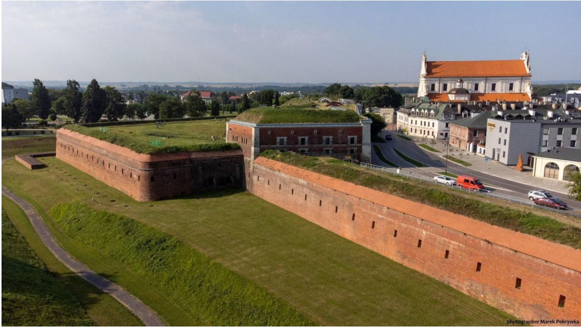
5 Twierdza Zamość, fragment fortyfikacji – bastion VII, nadszańiec, kurtyna, fot. M. Pokrywka, z zasobów UM Zamość
