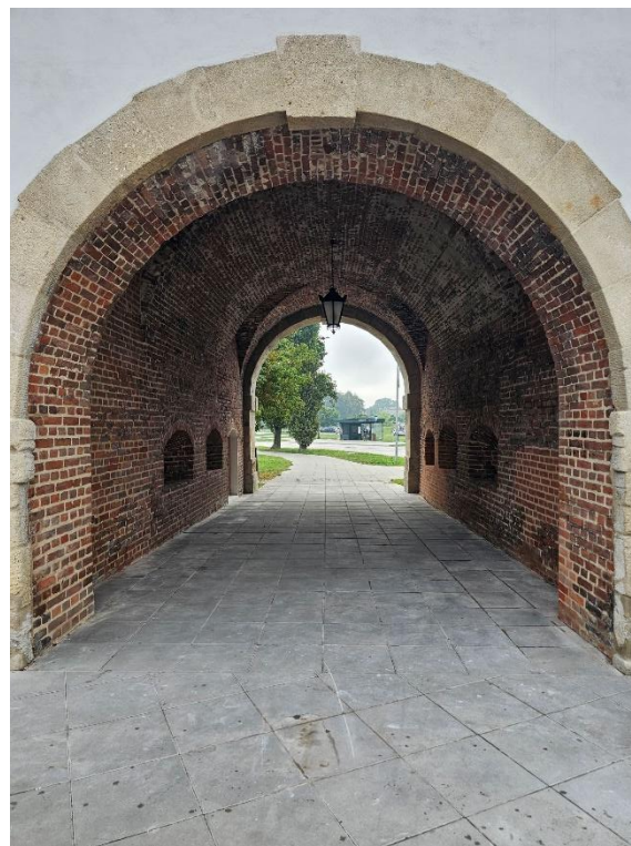
20 Brama Lwowska Stara po pracach remontowo-konserwatorskich, fot. R. Kondraciuk, z zasobów UM Zamość
