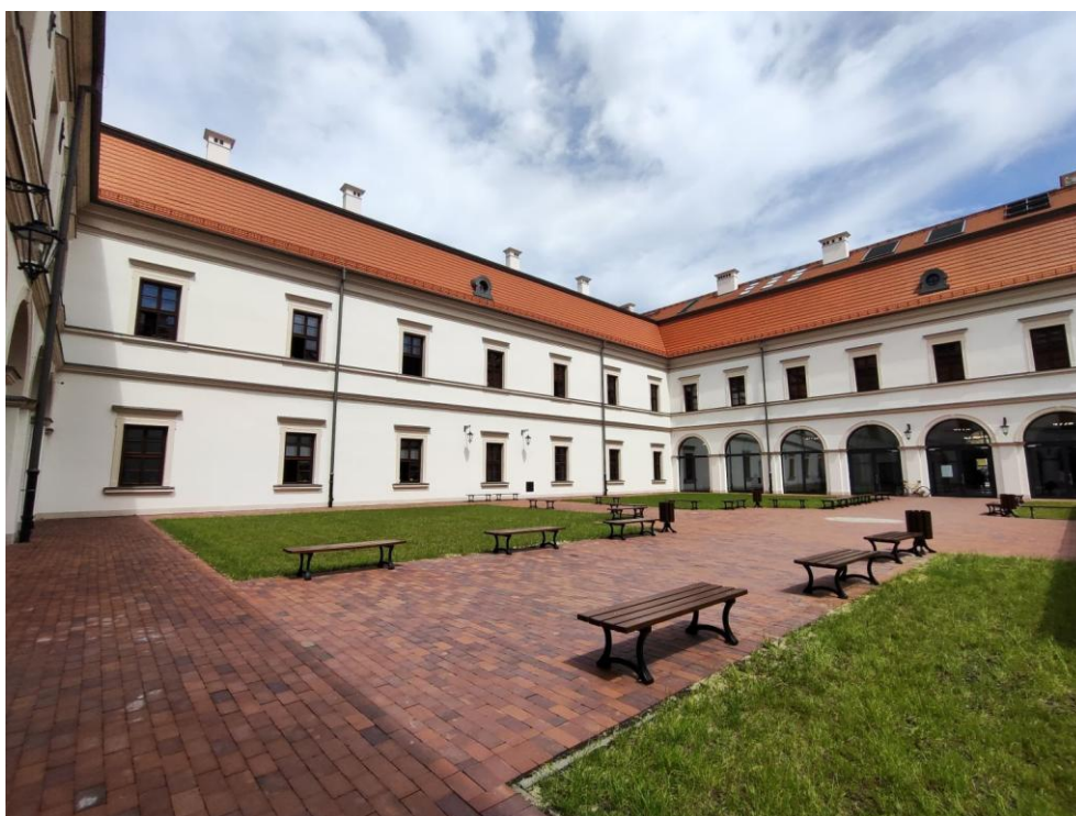
16 Akademia Zamojska, realizacja projektu „Rewitalizacja historycznego obiektu Akademii Zamojskiej w Zamościu” – remont konserwatorski i adaptacja do nowych funkcji, fot. M. Machlarz-Bondyra, z zasobów UM Zamość
