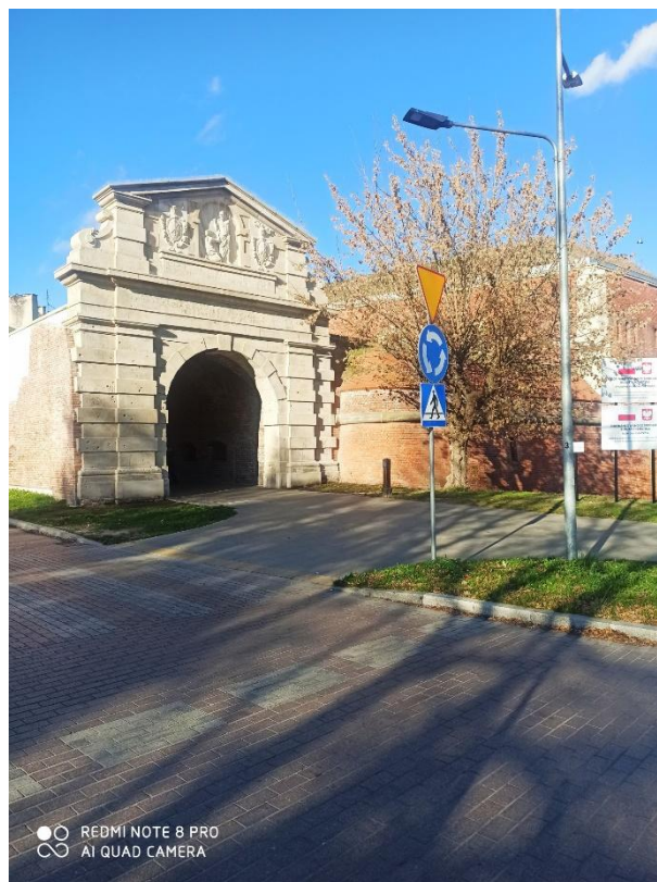
18 Brama Lwowska Stara po pracach remontowo-konserwatorskich, fot. R. Kondraciuk, z zasobów UM Zamość
