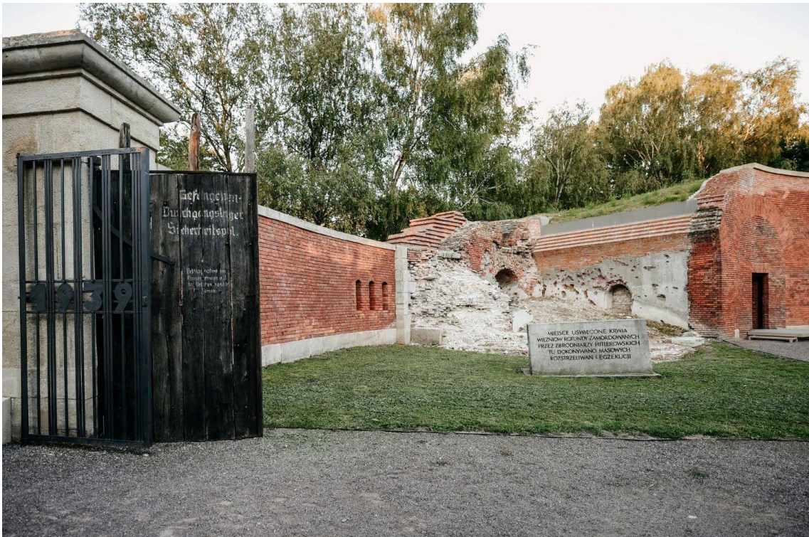
22 Rotunda, realizacja projektu „Rewitalizacja Rotundy Zamojskiej w Zamościu” – remont konserwatorski, rozbudowa ekspozycji muzealnej, fot. Sz. Łyciuk, z zasobów UM Zamość
